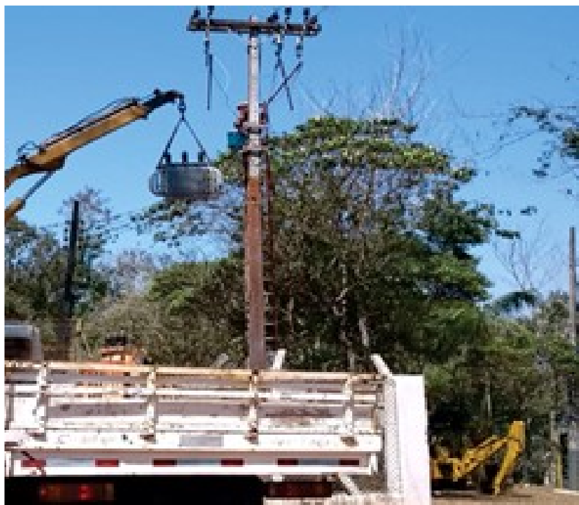
Figura 4 – Instalação típica de transformador com guindauto
